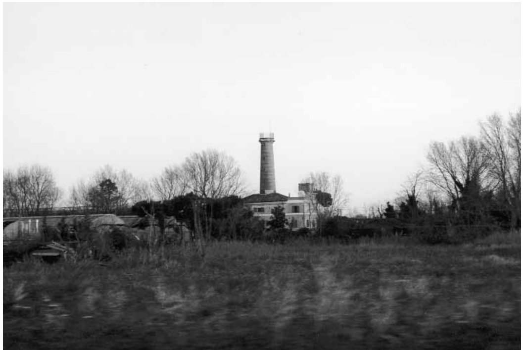
La Torre di Avvistamento usata dai Piloti del Porto nella seconda metà del 1800
